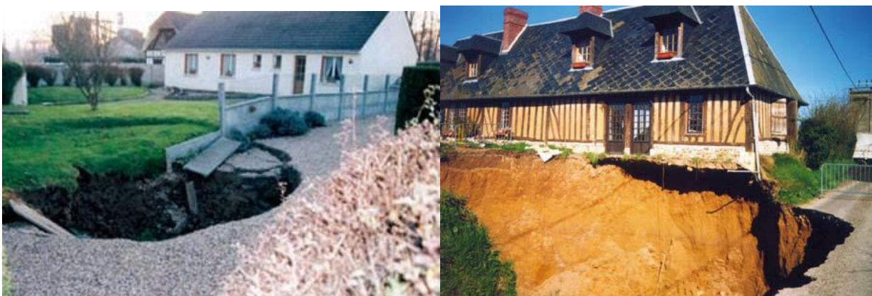
Effondrements de marnière en Seine Maritime et dans l'Eure
